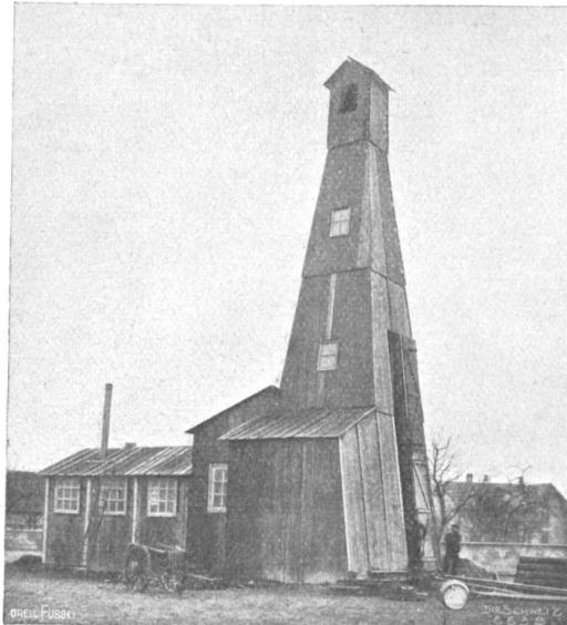
Bohrturm bei der Saline Ryburg bei Möhlin.
