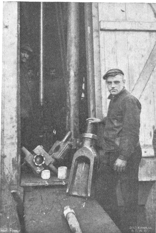
Bohrwerkzeuge und Blick in den Bohrturm.
