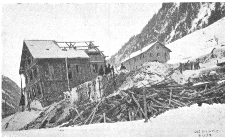
Zerstörung in Goppenstein durch eine Schneelawine.
