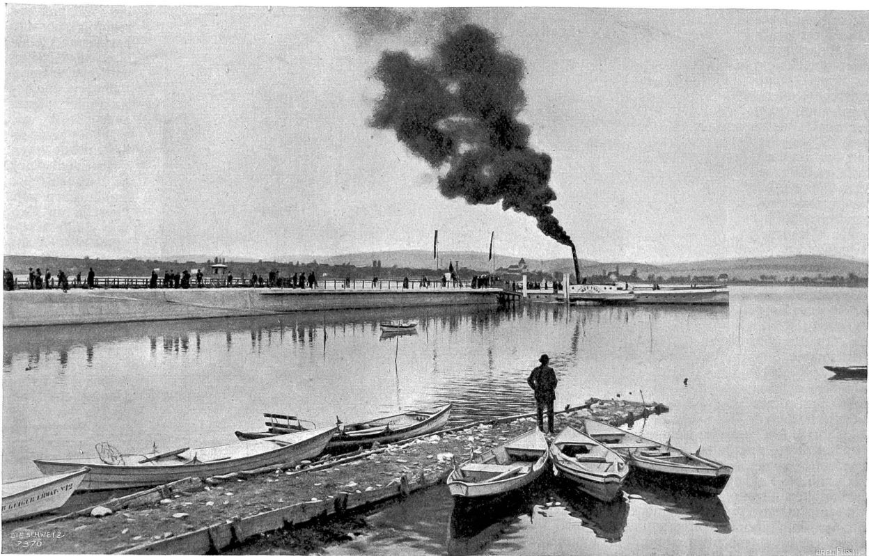
Die neue Hafenanlage in Ermatingen. Phot. Max Frei, St. Gallen.
