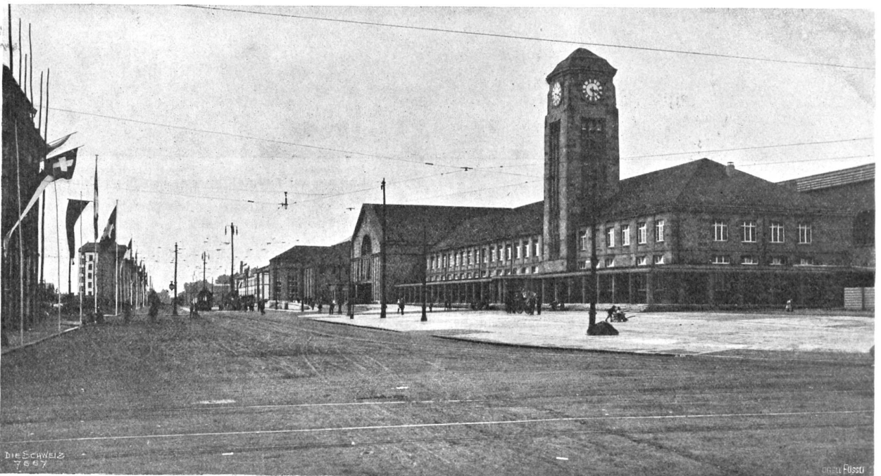
Der neue badische Bahnhof in Basel. Phot. A. Rainer, Basel.
