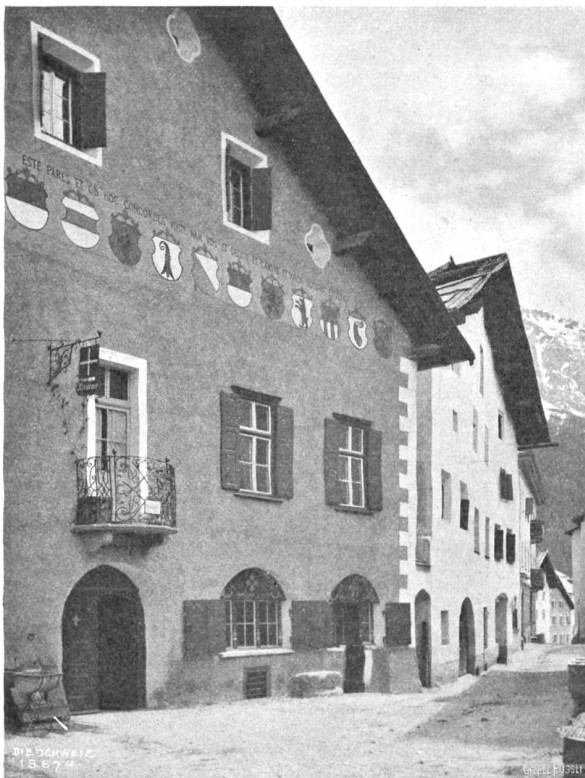
Schäfer & Risch, Chur. Teil der Mascaffade des 1909 umgebauten Gasthofs „Zum weißen Kreuz“ in Zuoz. Phot. Albert Steiner, St. Moritz.
