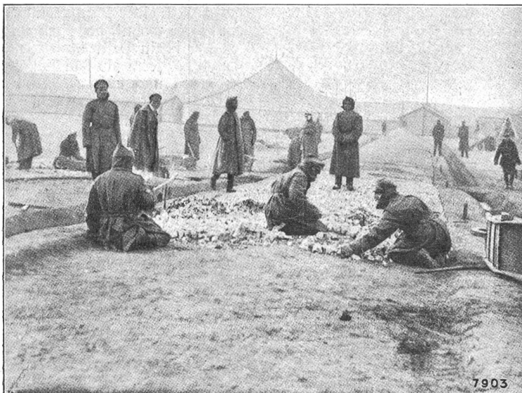
Aus einem russischen Gefangenelager in Ungarn: Russen beim Straßenbau.
