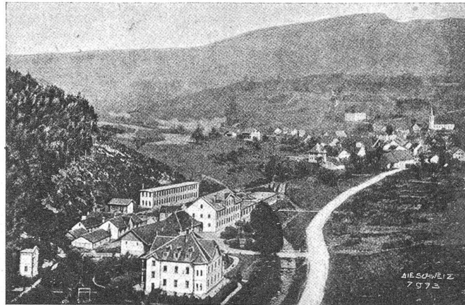
Mümliswil mit der durch Explosion zerstörten Kammerfabrik Walter-Obrecht.
