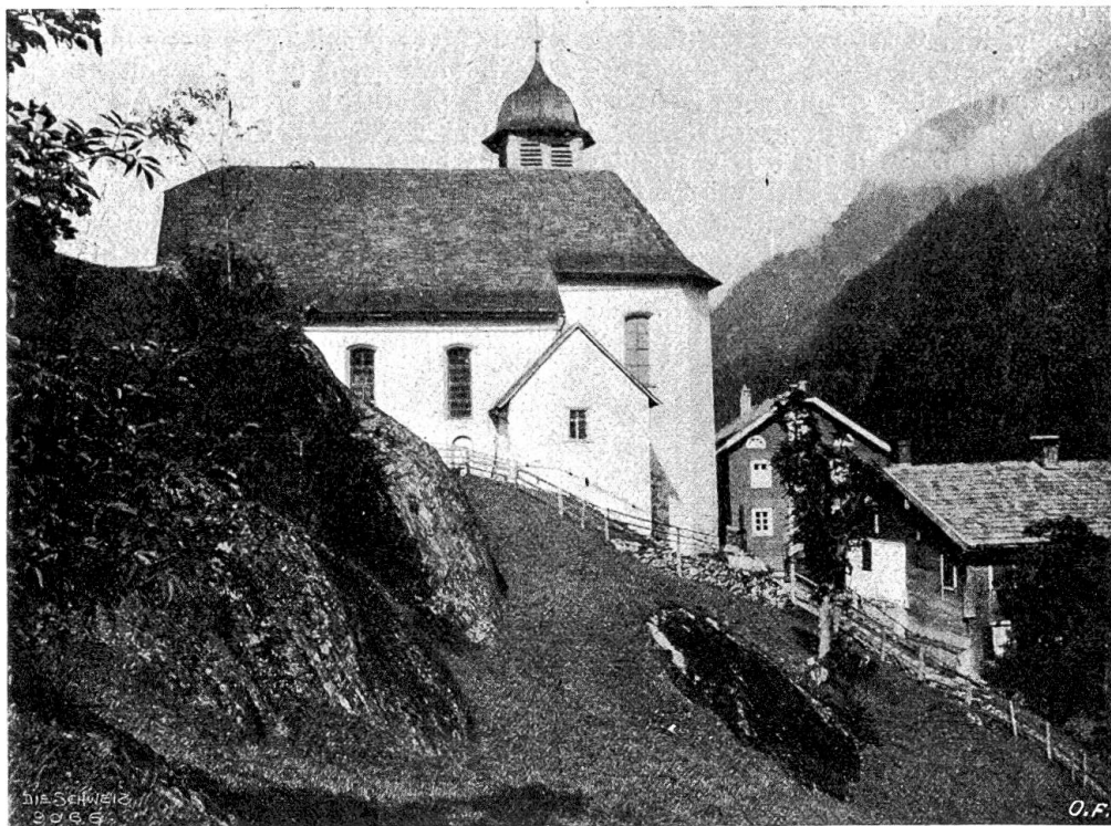
Kirche und Schulhaus zu Gurtellen, Kt. Uri, wo am 20. April eine Wandeltallawine niederging, die zwei Wohnhäuser und zwölf Ställe zerstörte. Phot. F. Sinder, Seon.
