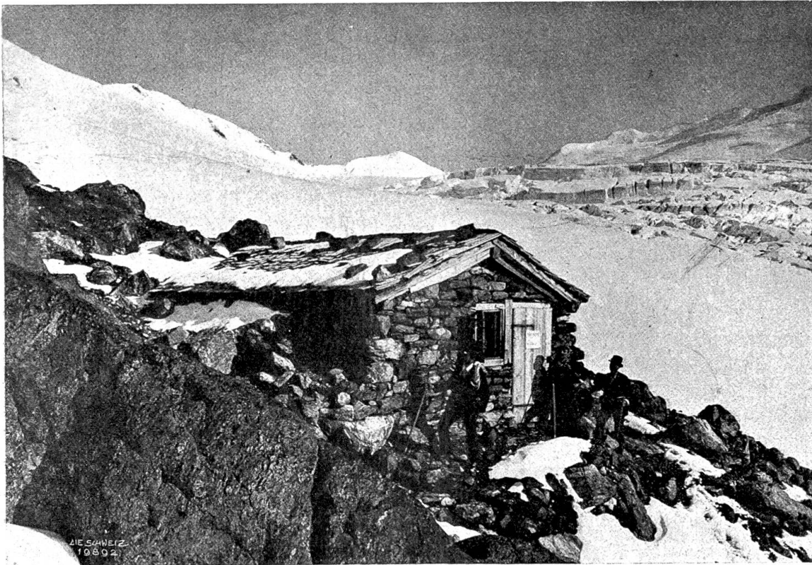
Klubhütten des S. A. C. Abb. 1. Die alte Trifthütte (der Sektion Bern), am rechten Ufer des Triftgletschers, am Fuß des Tälistockes, 2517 m ü. M., erbaut 1864, erneuert 1867. Phot. Wehrli N.-G., Kilchberg-Zürich.
