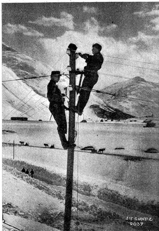
Schweiz. Grenzbesetzung im Winter. Beim Leitungsbau. Phot. Jean Gaberell, Thalwil.
