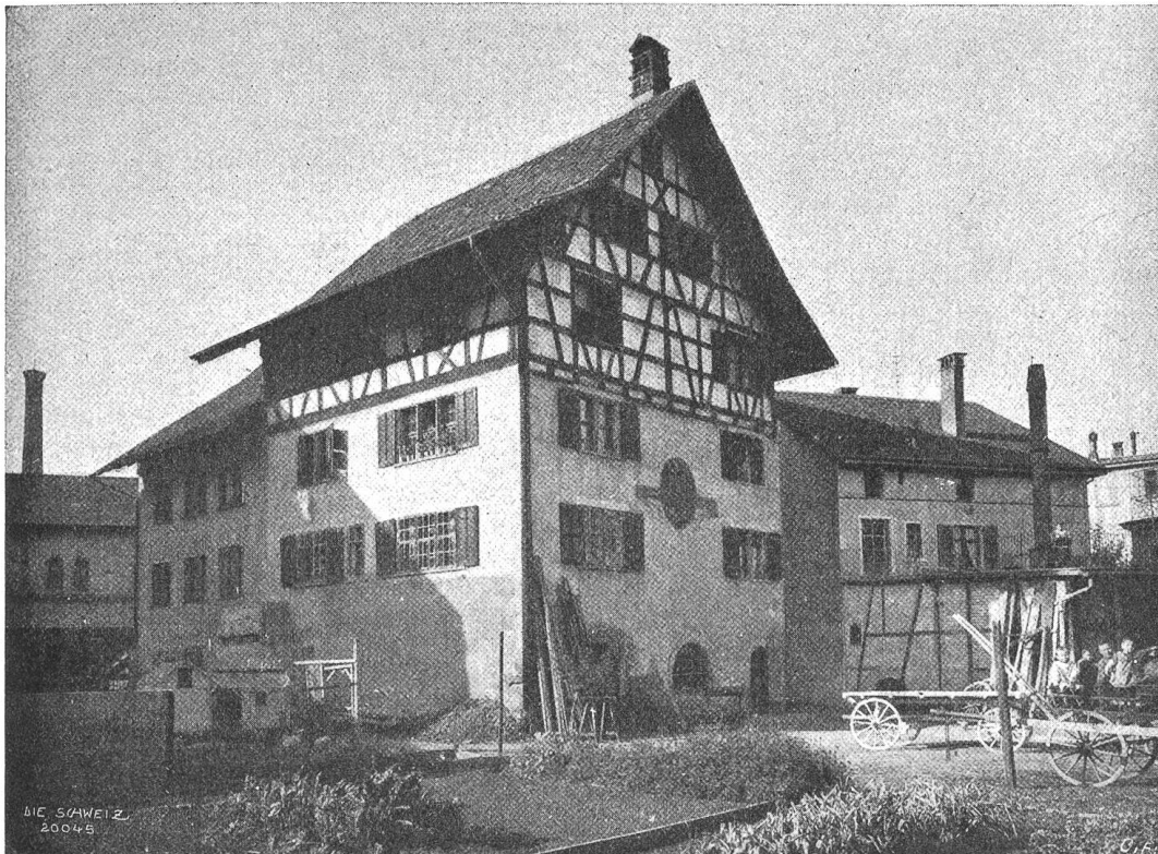
Die zum Abbruch bestimmte „Blumenbleiche“ in Winterthur. Phot. S. Jäggi, Winterthur.
