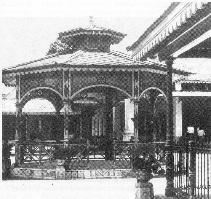
Pavillon im Sultanspalast Kraton in Yogyakarta
