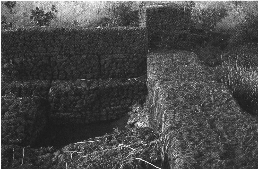
Fig. 5. — Barrage en gabions sur un corry. Ce type d'ouvrage permet de stopper l'érosion latérale dans le lit majeur et d'étaler les crues. Il doit jouer un double rôle, colmater les bas-fonds et recharger les nappes.
