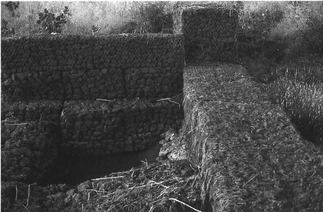
Fig. 5. — Barrage en gabions sur un corry. Ce type d'ouvrage permet de stopper l'érosion latérale dans le lit majeur et d'étaler les crues. Il doit jouer un double rôle, colmater les bas-fonds et recharger les nappes.
