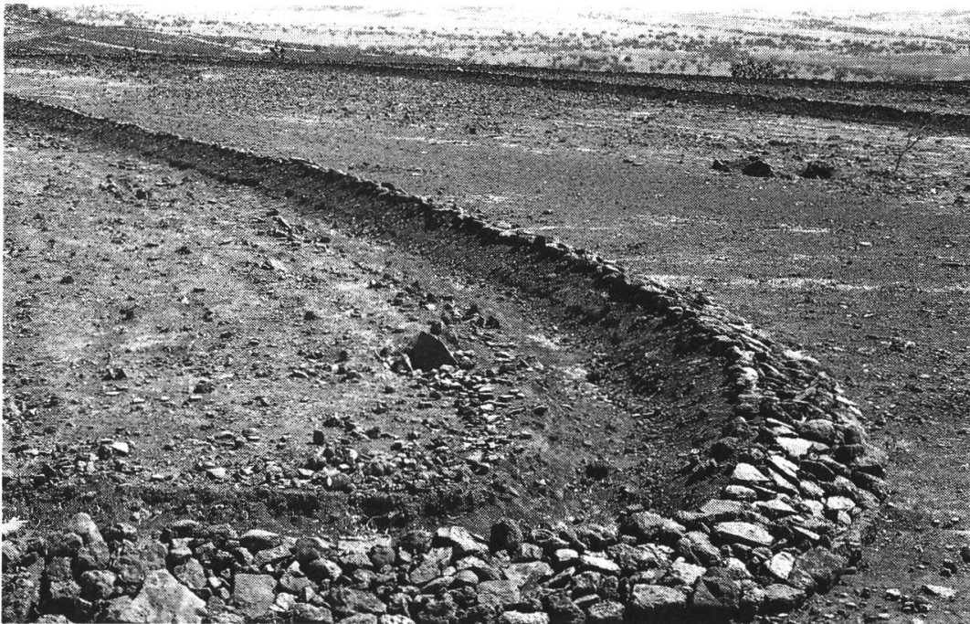
Fig. 8. — Banquettes anti-érosives. Traitement d'un versant dans le but d'infiltrer un maximum d'eau et de retenir le sol. L'empierrement de ces banquettes est un travail extrêmement pénible.
