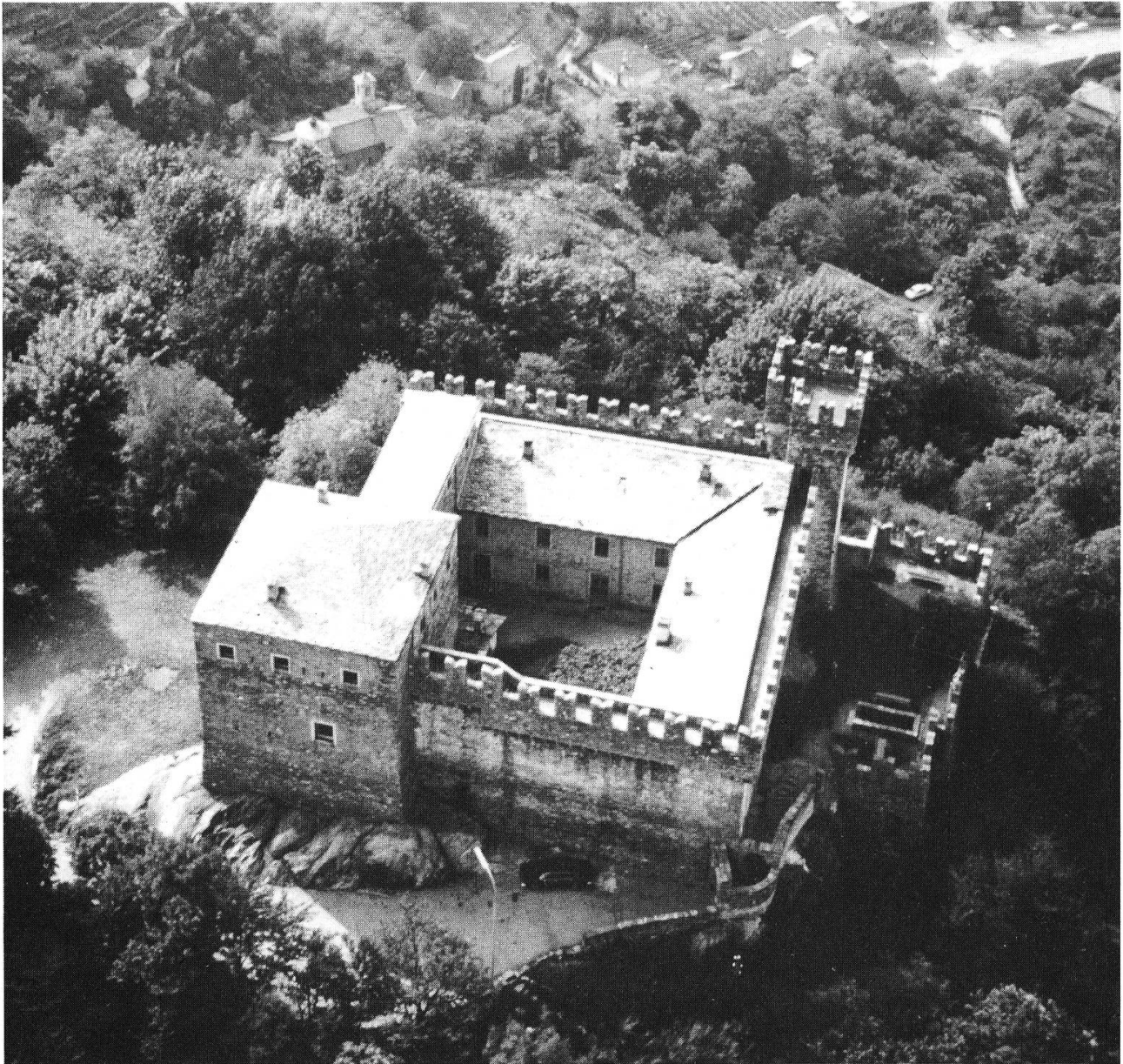
Le château de Sasso Corbaro (vue aérienne).
