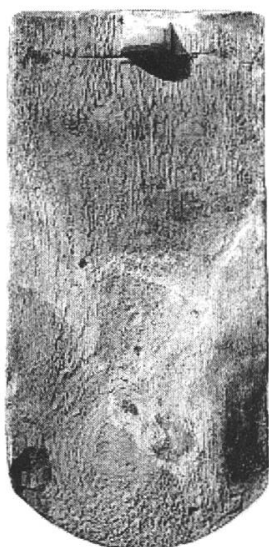
Fig. 3. Négatif de la planchette ayant servi de foncet visible sur la surface intérieure d'une tuile moulée «à l'allemande» (MHAVD 8/14)
