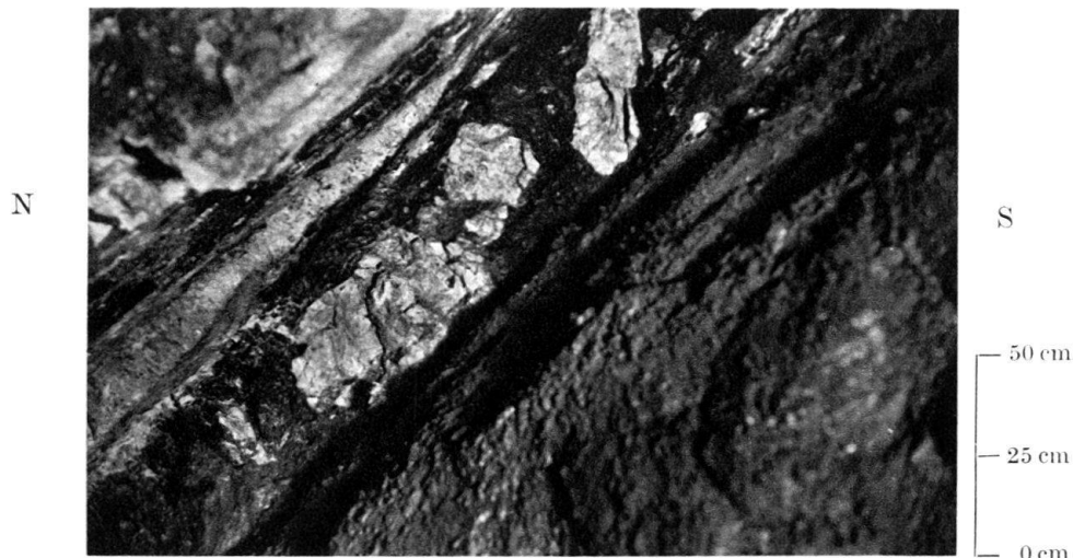
Fig. 8. Gleiche Kluft wie in Fig. 7. Brocken von gelblich-braunem Lehm sind in mulmiger Kohle eingebettet. Aufn. aus Abbaustrecke 1780 ca. 115 m west-nordwestlich von Schacht Cornu.
