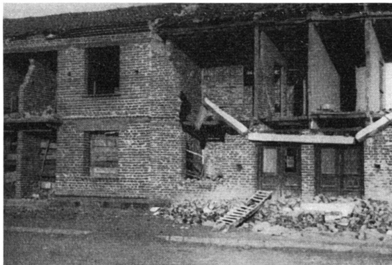
Fig. 7. Backsteinhäuser in Çan mit horizontalen Betonverstärkungen, Stoss von seitwärts zerstörend, senkrecht zur Stossrichtung orientierte Wände eingestürzt.
