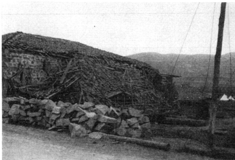
Fig. 8. Gemischte Konstruktion in Çan, seitwärts gestürzt.
