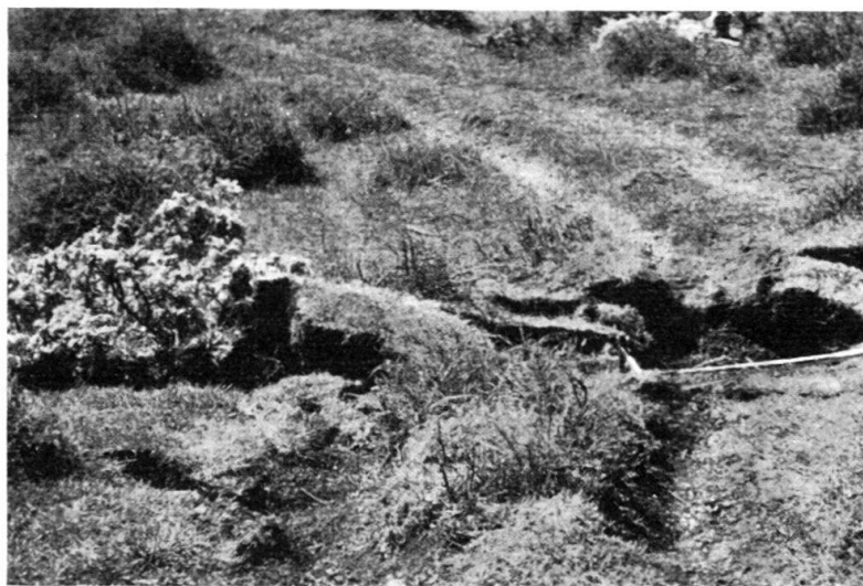
Fig. 12. Versetzung an Feldweg etwa 1 km nordöstlich von Muratlar (südwestlich von Gönen). Verschiebungsbetrag 1,5 m (vgl. Ansichtsskizze Fig. 11).
