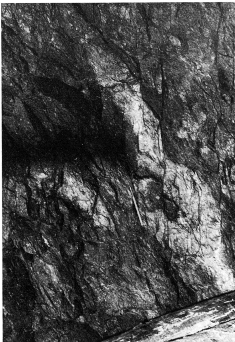
Fig. 14. Eine aplitische Lage im tektonisierten Innertkirchner-Granit wird mehrfach an einem System vertikaler, Nordost - Südwest streichender Verschiebungsflächen versetzt. Die Südostflügel sind relativ abgesenkt. Druckstollen Trift-Speicherberg, m 3897 ab Trift.
