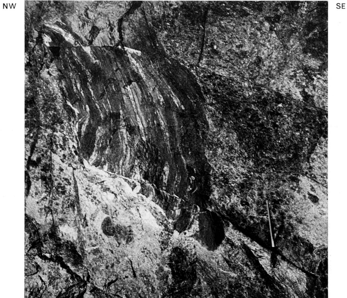
Fig. 10. Massiger Innertkirchner-Granit mit Biotitgneis-Scholle. An zwei Stellen wird die Scholle durch Überschiebungsflächen versetzt. Druckstollen Trift-Speicherberg, m 1729 ab Trift.
