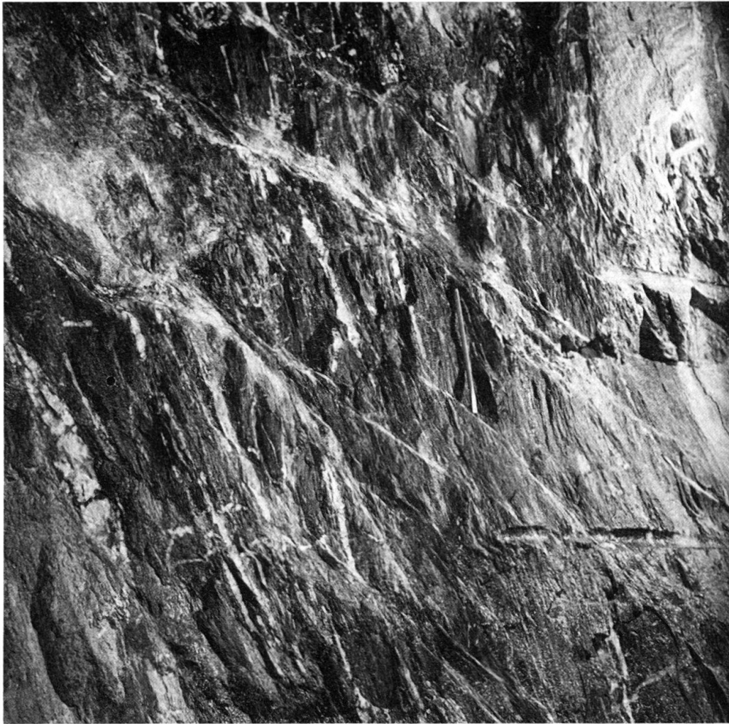
Fig. 6. In intensiv verschiefertem Innertkirchner-Granit erkennt man die steil südostfallende Schieferung und die jüngeren, flachliegenden Überschiebungsflächen. Druckstollen Trift-Speicherberg, m 2783 ab Trift.
