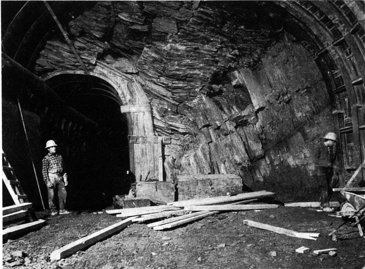
Fig. 4. Grenze Fels–Hakenwurf im Riedtunnel der N2, Blick gegen E. Das Reusstobel liegt weiter links.
