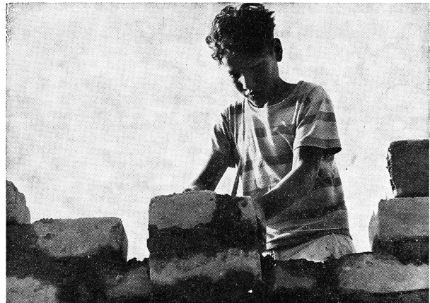
Comment les aider à sortir de leur misère ? En soutenant les organisations qui ont pour but de leur donner une formation scolaire et professionnelle. Ici, un jeune Indien garçon qui, grâce à l'Aide suisse à l'étranger, fait un apprentissage de maçon
