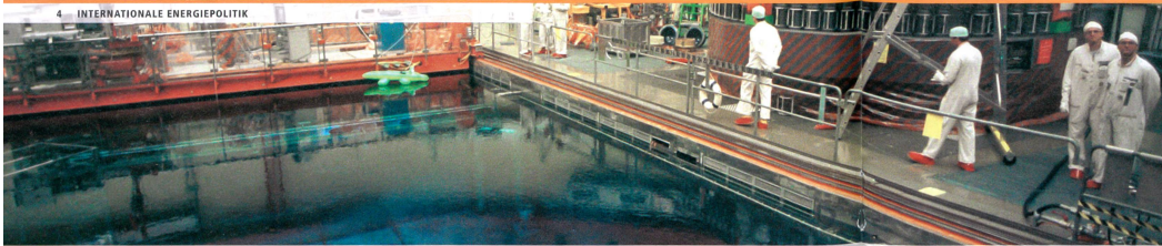
Reaktorhalle mit Trennelement-Transferbecken im Kernkraftwerk Leibstadt
