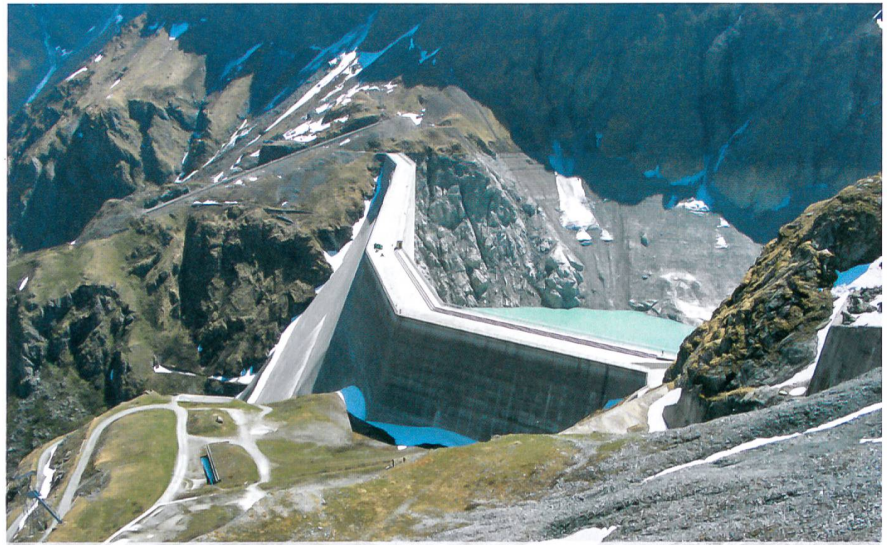
Mit der Grande Dixence hat die Schweiz die höchste Betonstaumauer der Welt.
