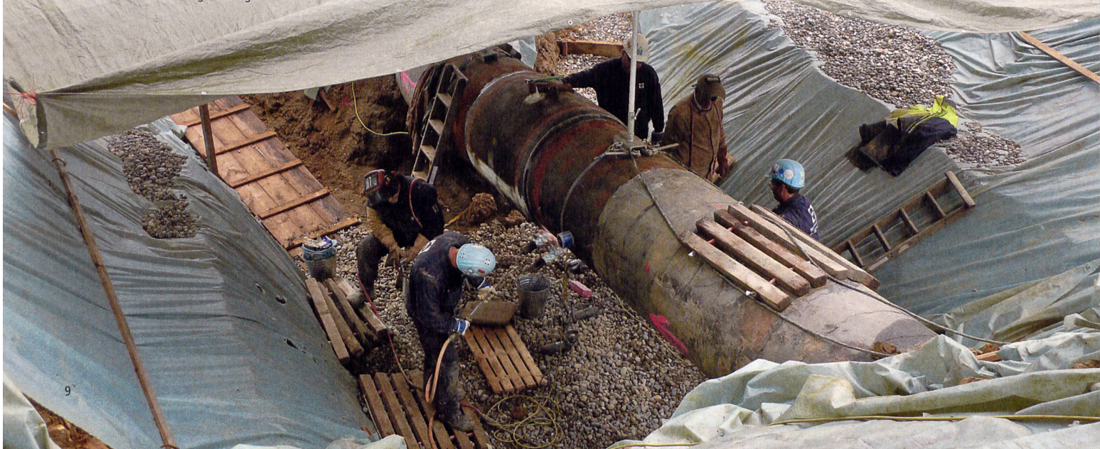
Bauarbeiten an der Transitgasleitung
