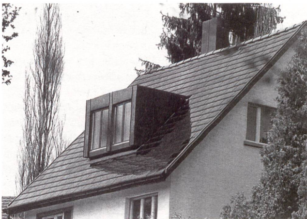
Dacherneuerung mit integrierten Sunslates (BS)
