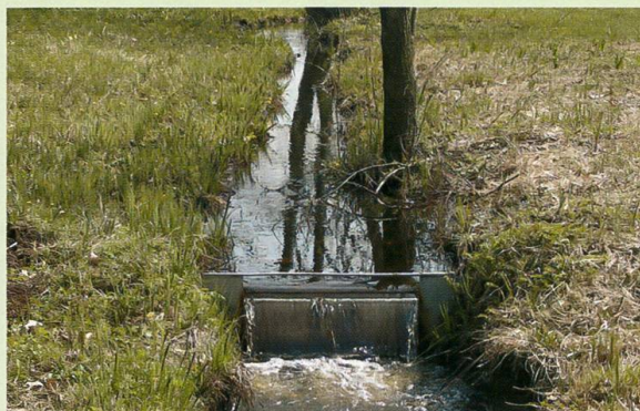
Abb. 3. Dieses Stauwerk besteht aus Edelstahl mit einer demontierbaren Platte.
