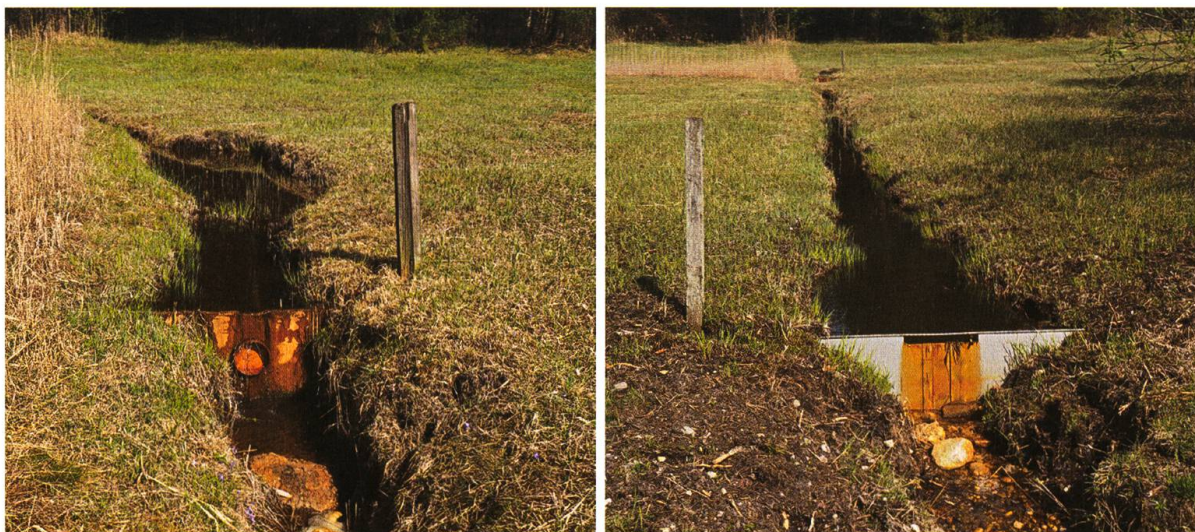
Abb. 2. Zwei Typen von Stauwehren in den Gräben des Chuderriets. Links: Stauwehr S4. Einfache Holzkonstruktion mit rundem Plastikpfropf zum Wasserablass. Rechts: Stauwehr S3. Metallkonstruktion mit demontierbarer Platte. Steine unter dem Wehr verhindern die Auskolkung des Gewässergrundes bei verstärktem Wasserabfluss. Die Rostfarbe beruht auf natürlichen Eisenausfällungen im Wasser. 30.03.2017. (Fotos Hansruedi Wildermuth)
