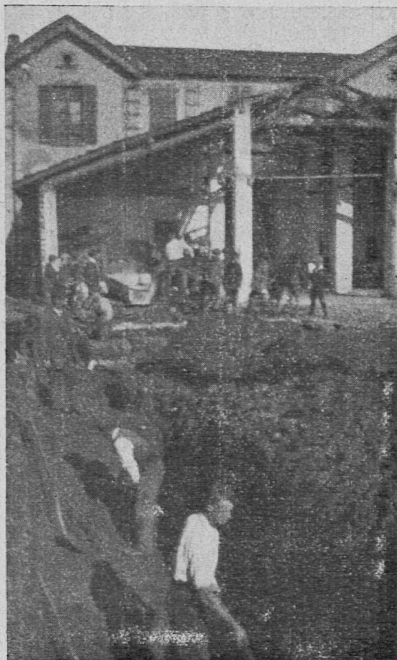
Lo scavo delle fondamenta. (24 ottobre 1924).
