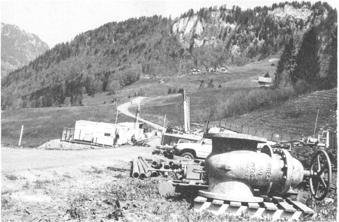
Die letzte Sondierbohrstelle der Nagra am Wellenberg.
