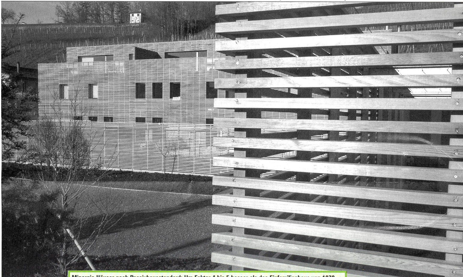
Minergie-Häuser nach Passivhausstandard: Um Faktor 4 bis 5 besser als das Einfamilienhaus von 1970.
