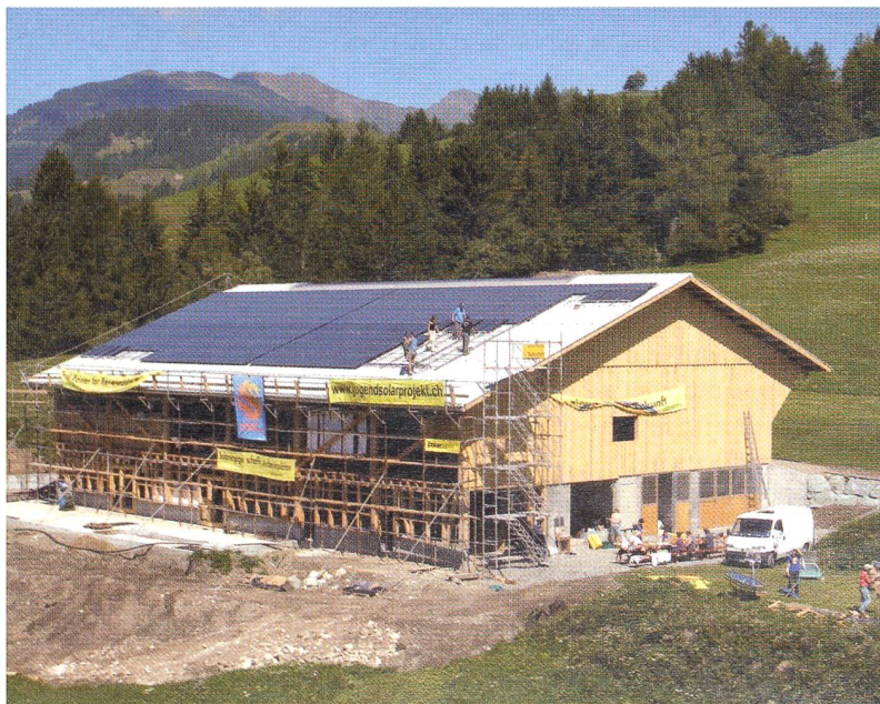
Bau einer 35-kW-Solarstromanlage auf einem Scheunendach in Brienz/Brienzauls, erstellt von Solarspar und dem JugendSolarprojekt von Greenpeace. Am 1. Mai wurden für das JugendSolarProjekt 11 KEV-Gesuche für Photovoltaik-Anlagen, mit einer Gesamtleistung von zirka 500 kW, bei swissgrid eingereicht. Seit 1988 realisierte das Greenpeace JugendSolarProjekt insgesamt 160 Solaranlagen, PV und thermisch. Die Photovoltaik-Anlagen haben eine Gesamtleistung von zirka 1 MW.
