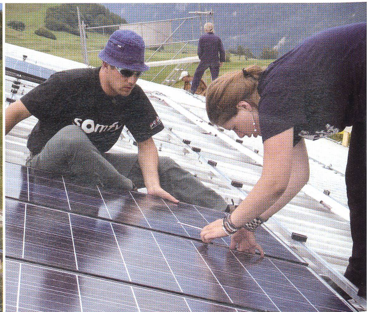
Bau einer 35-kW-Solarstromanlage auf einem Scheunendach in Brienz/Brienzauls, erstellt von Solarspar und dem JugendSolarprojekt von Greenpeace. Am 1. Mai wurden für das JugendSolarProjekt 11 KEV-Gesuche für Photovoltaik-Anlagen, mit einer Gesamtleistung von zirka 500 kW, bei swissgrid eingereicht. Seit 1988 realisierte das Greenpeace JugendSolarProjekt insgesamt 160 Solaranlagen, PV und thermisch. Die Photovoltaik-Anlagen haben eine Gesamtleistung von zirka 1 MW.
