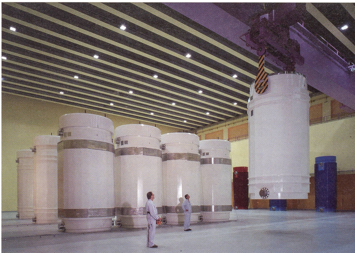
Im Zwischenlager in Würenlingen werden abgebrannte Brennelemente in massiven Behältern gelagert, bis das bestmögliche Tiefenlagerkonzept gefunden und umgesetzt werden kann.
