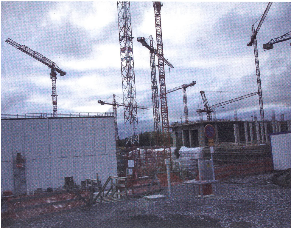
Baustelle des EPR-Reaktors in Olkiluoto/Finnland im Oktober 2006 – ein teures Verlustgeschäft für den französischen Atomkonzern Areva.
