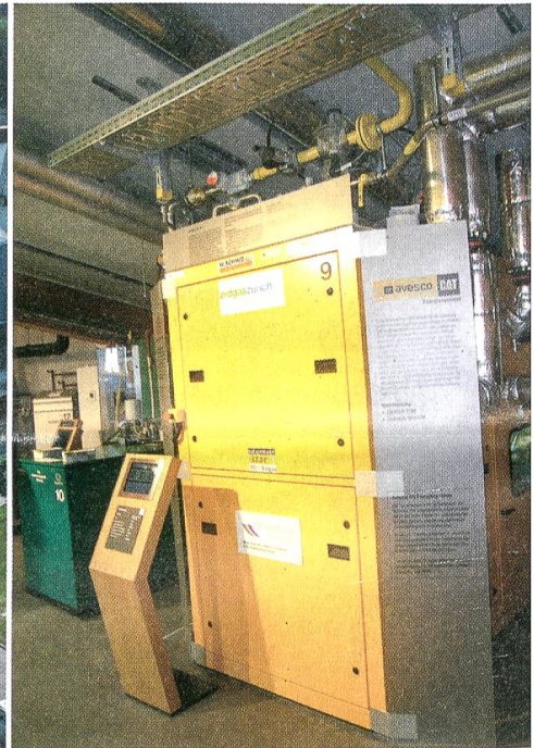
Jüngstes Beispiel für die ideale Kombination von Photovoltaik und Wärme-Kraft-Kopplung ist die Umweltarena in Spreitenbach von Kompogas-Erfinder Walter Schmid: Das Block-Heiz-Kraftwerk (BHKW) der Umweltarena nützt das Biogas der eigenen Kompogasanlage zur Strom- und Wärmeversorgung.
