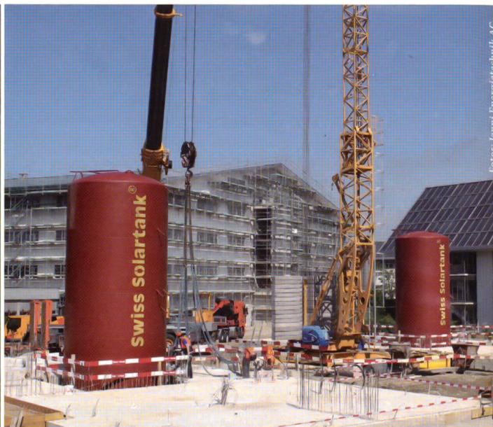
Die drei Mehrfamilienhäuser im Solarpark in Oberburg BE werden zu 100% mit Sonnenenergie für Heizung und Warmwasser versorgt. Mit grossen Wasserspeichern lässt sich Wärmeenergie mit Abstand am günstigsten speichern – vor allem auch saisonal.
