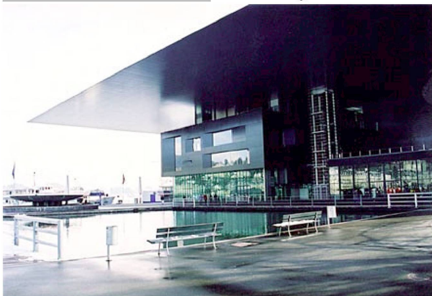
Kultur- und Kongresszentrum Luzern, Architekt Jean Nouvel, Paris
