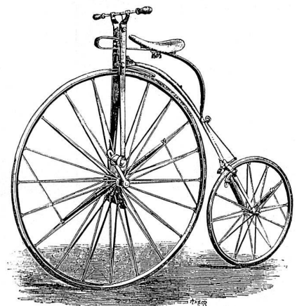
Bild 14: Hochrad aus der Fabrik von Smith, Starley & Co., Coventry. Leistung: «12 to 15 miles per hour». Aus: The Mechanics Magazine; vol. 28, 1872, p. 279.
