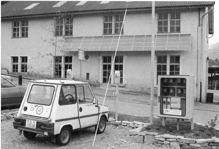
Solare Park + Ride-Anlage beim Bahnhof in Liestal.
