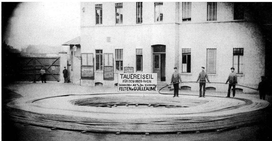
Tauereiseil für den Oberrhein, Seillänge 36 000 Meter! (Carlswerk-Archiv, Felten & Guillaume, Köln).
