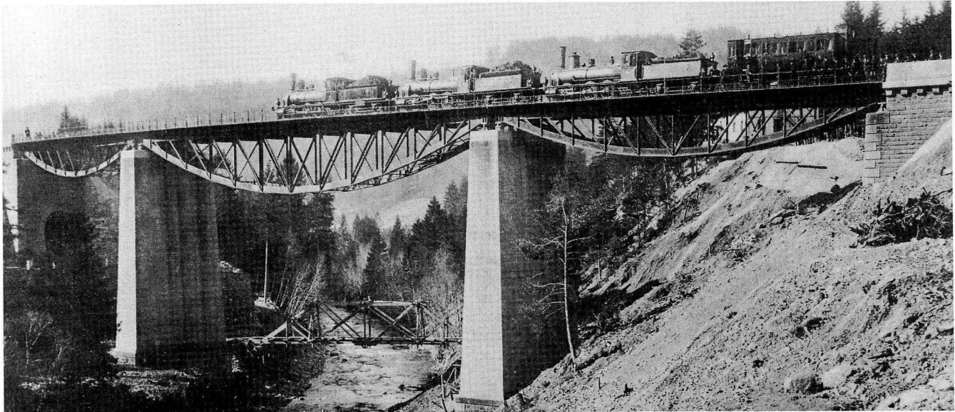
Wutachbrücke unter Belastungsprobe.
