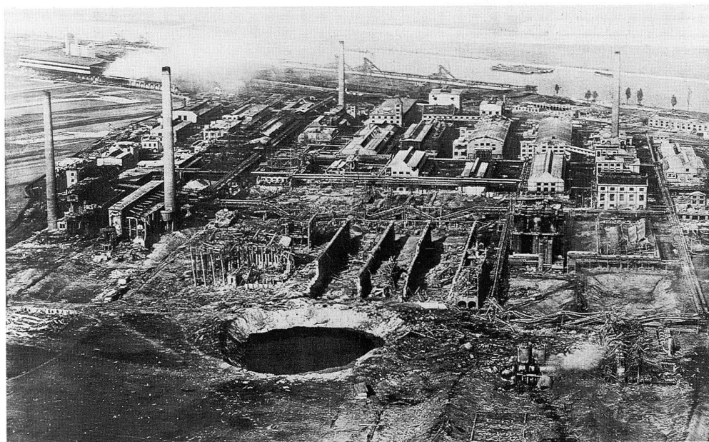
Luftaufnahme des Werkes Oppau der BASF unmittelbar nach der Explosion am 21. September 1921 (BASF Aktiengesellschaft, ZA/MU Umfeldkommunikation / Unternehmensarchiv, Dr. Meinzer)
