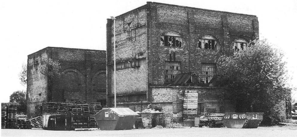
Aussenfassade der letzten noch erhaltenen Gebäude der Rheinischen Gummi- und Celluloidwaren-Fabrik Mannheim; gut sichtbar die obere abgesetzte fensterlose Dach-Ummauerung. (Dokumentation 1996; Foto: Sammlung Oelsner)
