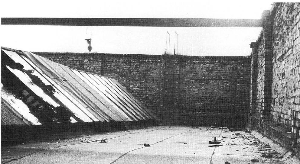
Flach-Dachkonstruktion mit der fensterlosen Dach-Ummauerung für die Aufnahme der Wasserbehälter bzw. der Sandschüttung. (Dokumentation 1996; Foto: Sammlung Oelsner)
