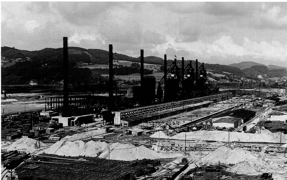
Abb. 5: Hochofenanlage der «Reichswerke» in Linz während des Baues, 18. Juni 1940. Die Hochofen 1, 2 und 3 (rechts) sind weitgehend fertiggestellt, für Ofen 4 stehen die Cowper-Winderhitzer und der Abgaskamin, für Ofen 5 und 6 nur die Abgaskamine. (Beginn der Roheisenerzeugung am 15. Oktober 1941 mit Ofen 1). Bildarchiv Köstler.
