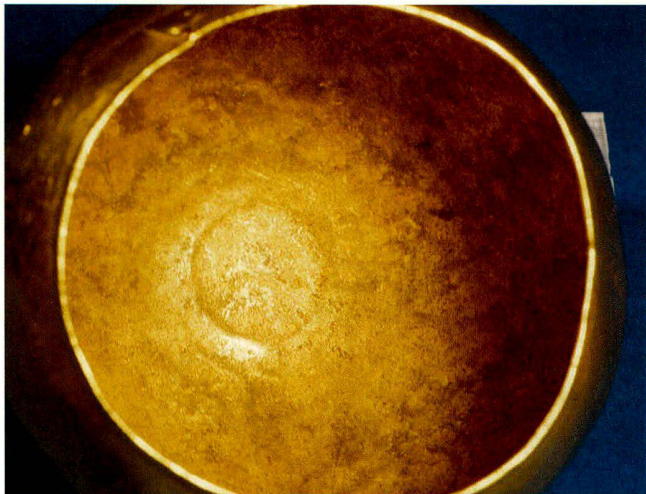
Detail eines Gefässes aus Caldas de Reyes: Die raue Gushaut ist an der Innenseite deutlich zu erkennen.
