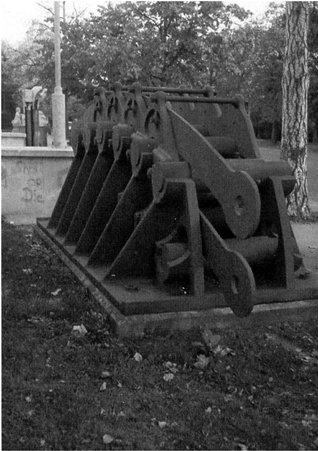
Gusseiserner Lagerblock der Budapester Kettenbrücke mit zwei gewalzten Gliedern der Tragkette, Anfang der 1840er Jahre.
