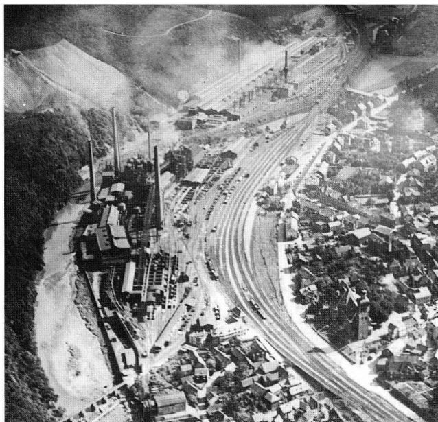
Luftbilder Hüttenwerke Siegerland AG, Werk Wissen, das die beengte Werksituation im Tal belegt, 1928.
