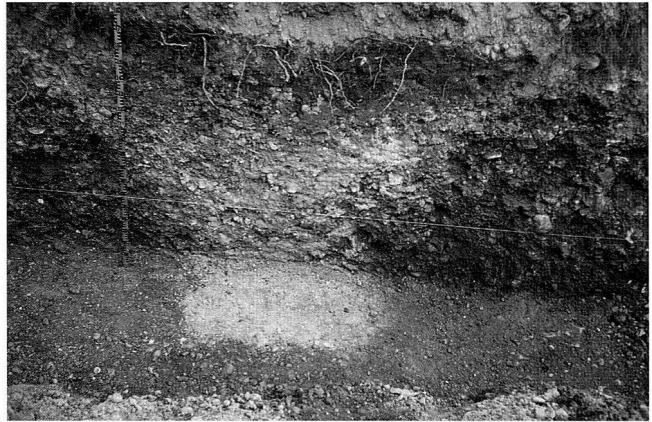
Bild 12: Drover-Berg-Tunnel bei Düren (Deutschland). Einer der Bauschächte des Tunnels, schon in römischer Zeit mit Ton verfüllt. (Foto: Klaus Grewe)
