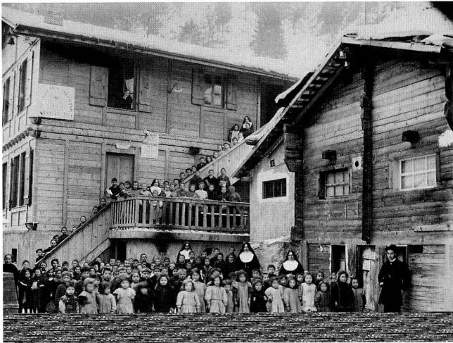
Bild 5: Die Tunnelschule in Goppenstein. (Foto: BLS-Archiv, Nr. 1737, Südportal)
