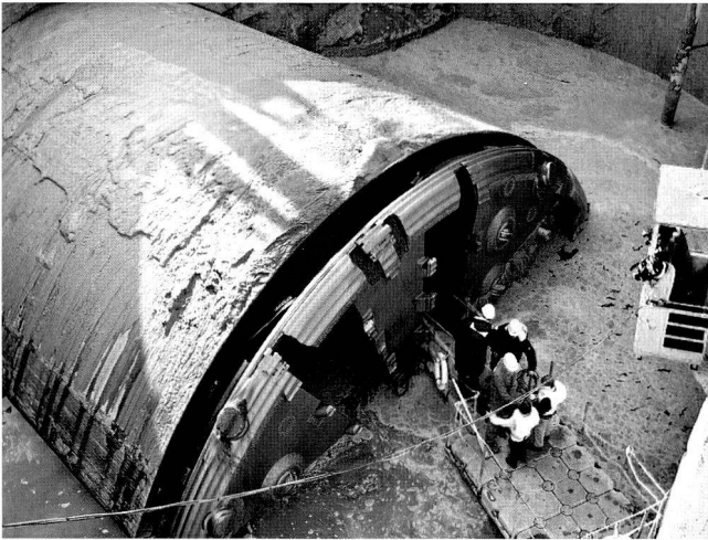
Bild 2: Einfahrt in den Zielschacht. (Foto: Herrenknecht AG)
