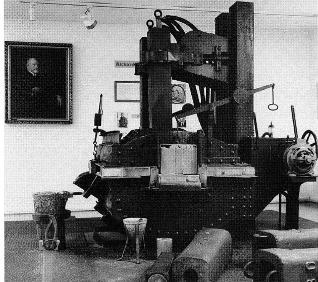
Bild 4: Elektrostahlöfen aus dem Stahlwerk Lindenberg 1906. (Foto: Uebbing, H., Wege und Wegmarken, Berlin 1991)
