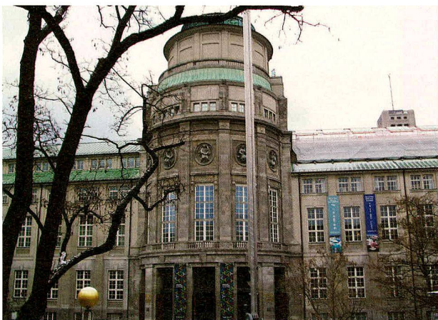
Eingangsfassade des Deutschen Museums in München mit dem Planetariumsturm.
